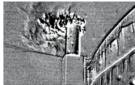
Bild 3 Gasverlust aus Überdrucksicherung infolge Falscheinstellung oder nicht optimierter Betriebsweise der Anlage.
